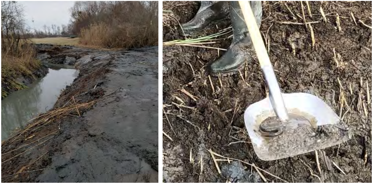
Abb. 2 Grabenräumung und geborgener Schlammpeitzger im März 2021 im Hauptgraben bei Hohenau
