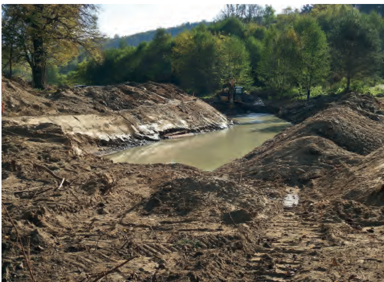
Errichtung der Laufverlegung in der KG Buchberg, Herbst 2022
