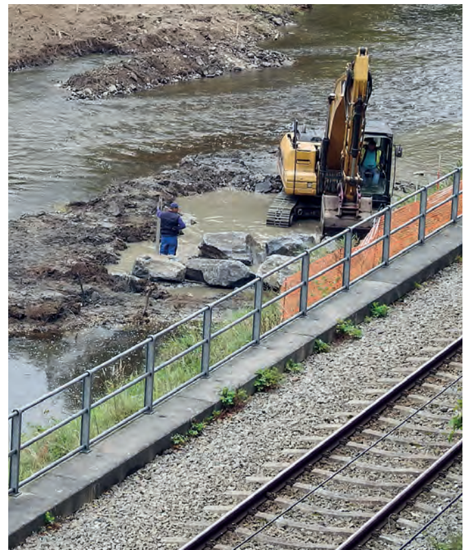
Errichtung einer Bühne mit Furt – Kolk – Furt Abfolge im Herbst 2021 in der KG Zitternberg
