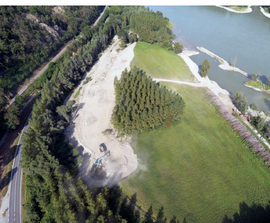
Aushub im Bereich des Altarms Ochsenschweif
