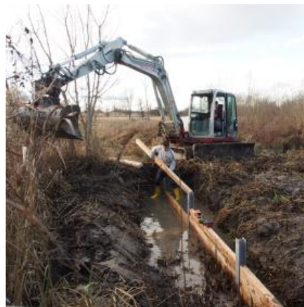
Einbau von Dammbalken; Foto: G. Käfel
