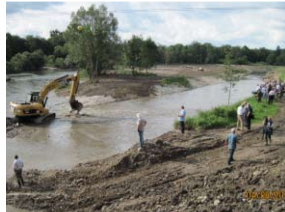
Durchstich des Nebenarms
