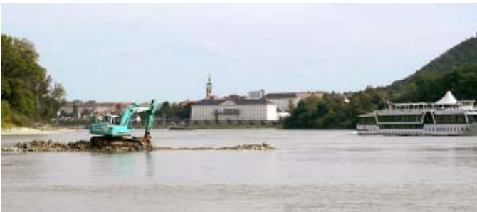
Mit dem Bühnenbau haben die eigentlichen Wasserbauarbeiten begonnen.
