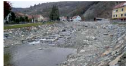
Nach Umbau die aufgelöste Rampe
