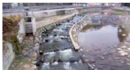
Pfannlwehr nach Umbau
